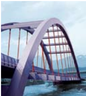
Egerndorfer Achbrücke, Wörgl, Tirol erbaut 2004
