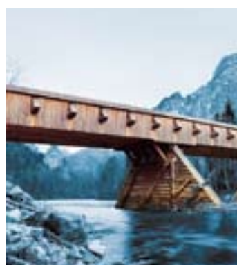
Lauferbauerbrücke, Gesäuse, Steiermark neu errichtet 2003
