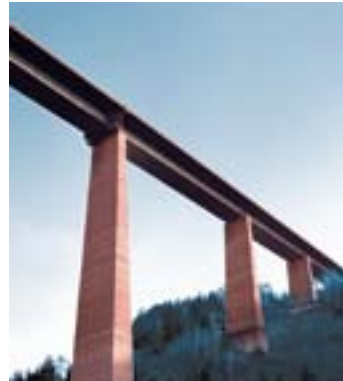
Europabrücke, Tirol erbaut 1959–1963
