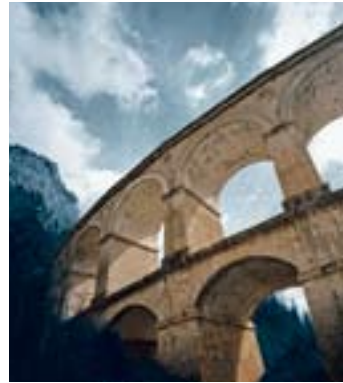
Viadukt Ghega-Bahn, Semmering
