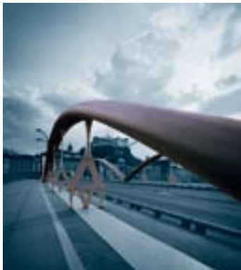
Nonntaler Brücke, Salzburg
